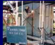
鋼板巻立工の施工状況
