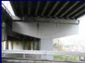
T型橋脚; 梁部 (梁幅11.0m x 梁厚2.0m)
