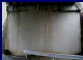
橋台 (高さ6.5m x 幅11.0m)
