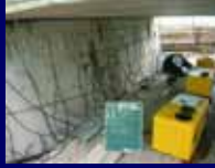
【本加圧注入状況】
