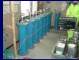
本加圧注入状況 (気圧式加圧装置)
