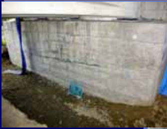
西庄高架橋（国道11号）橋台
