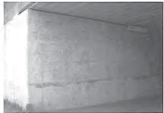
写真-2 陶橋一施工後4年経過した外観状況
