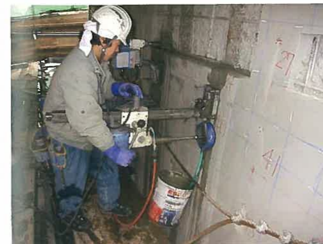
ダイヤモンドコアドリルによる削孔
