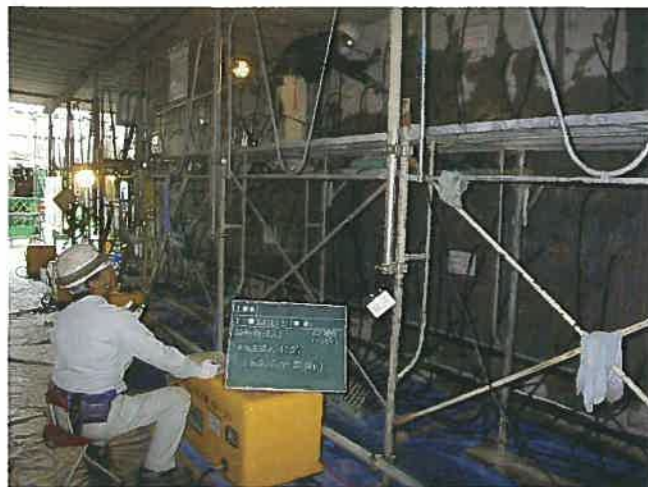
本加圧注入状況
