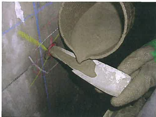
無収縮グラウト材による圧入孔充てん
