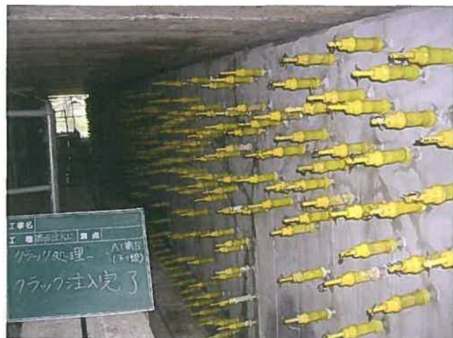
ひび割れ注入
