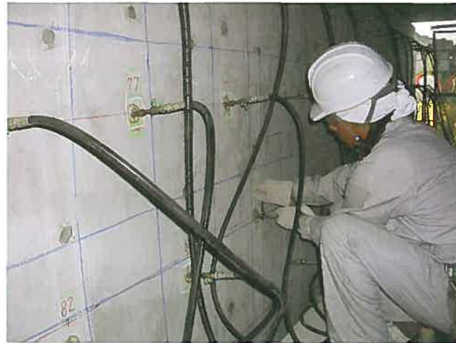
試験加圧注入状況
