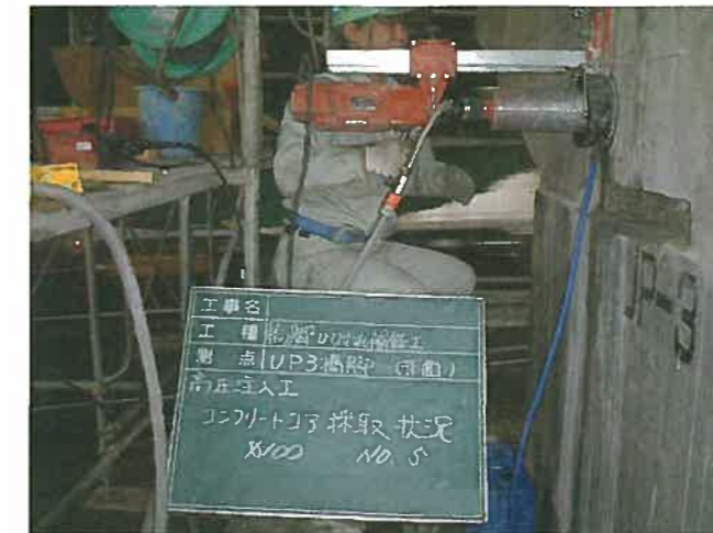
残存膨張量試験用のコア採取状況
