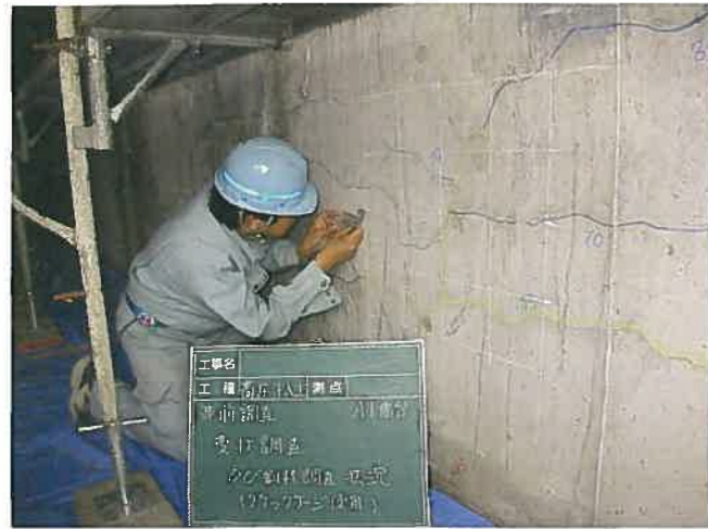
ひび割れ幅、ひび割れ延長調査
