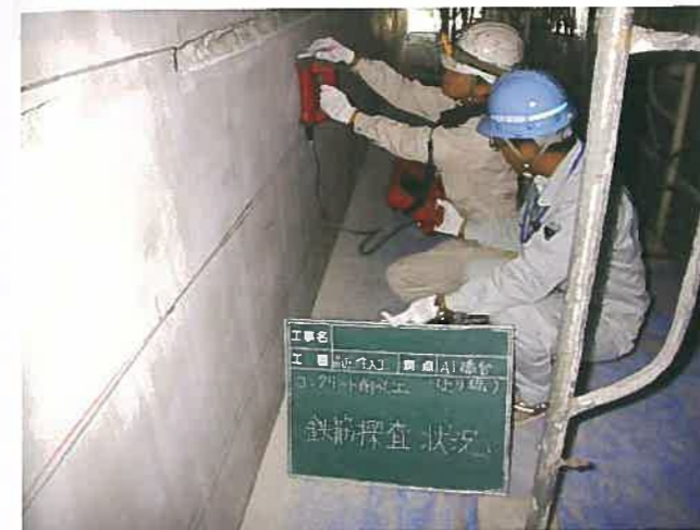
鉄筋探査状況
