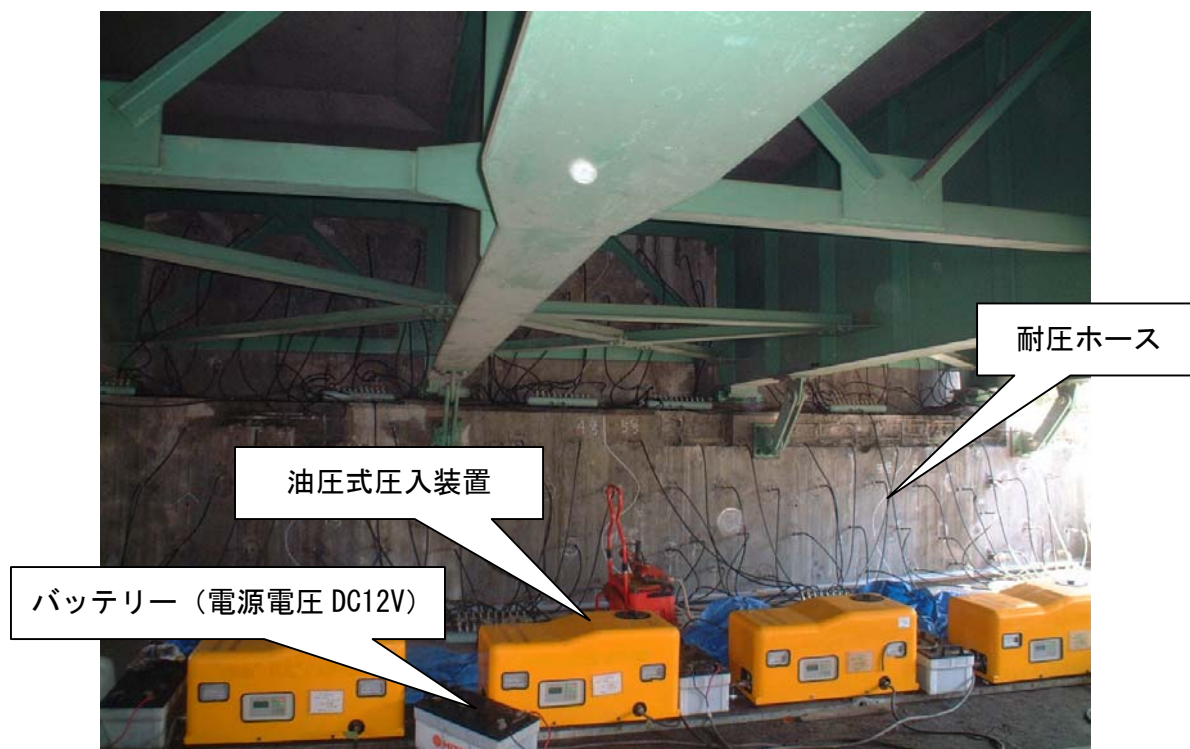
図 3.3-8 油圧式圧入装置とバッテリーの配置例
