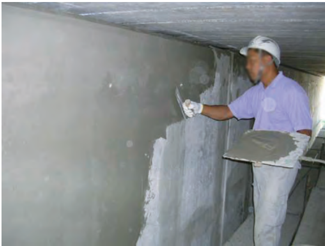
②表面被覆（シール工）
