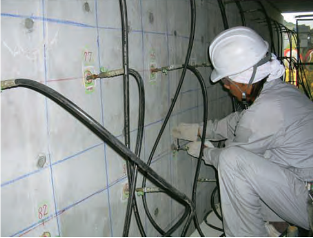
試験加圧注入
