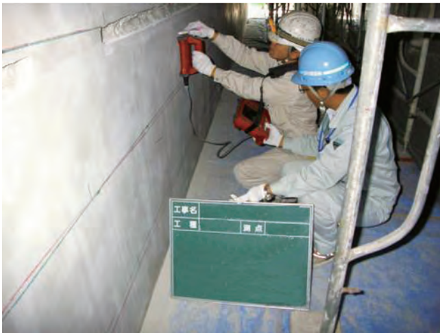
鉄筋探査
