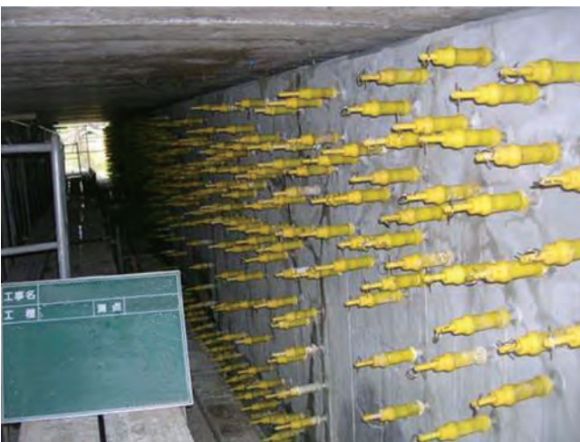
①ひび割れ注入
