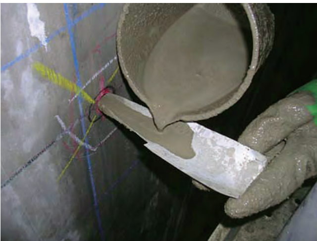
無収縮グラウト材による圧入孔充填
