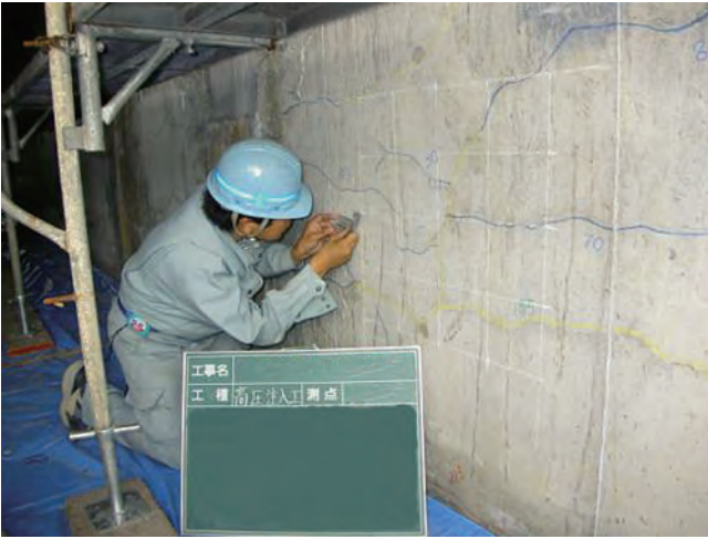
①ひび割れ幅，ひび割れ延長調査
