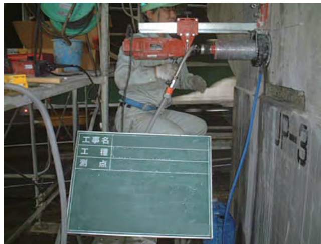
残存膨張量試験用のコア採取状況
